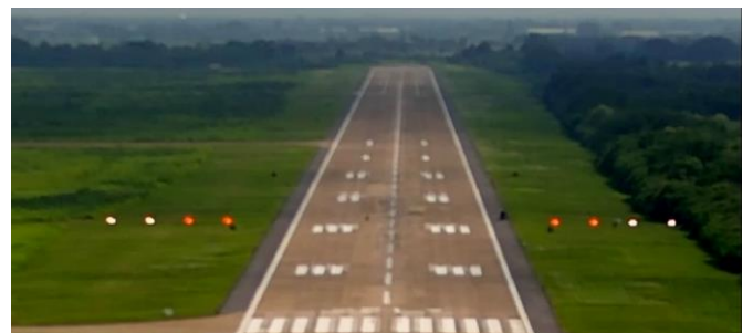
ภาพที่ 10 ไฟ PAPI หลังปรับมุมด้วยโดรน ไฟซ้ายและขวาตรงตามมาตรฐาน
